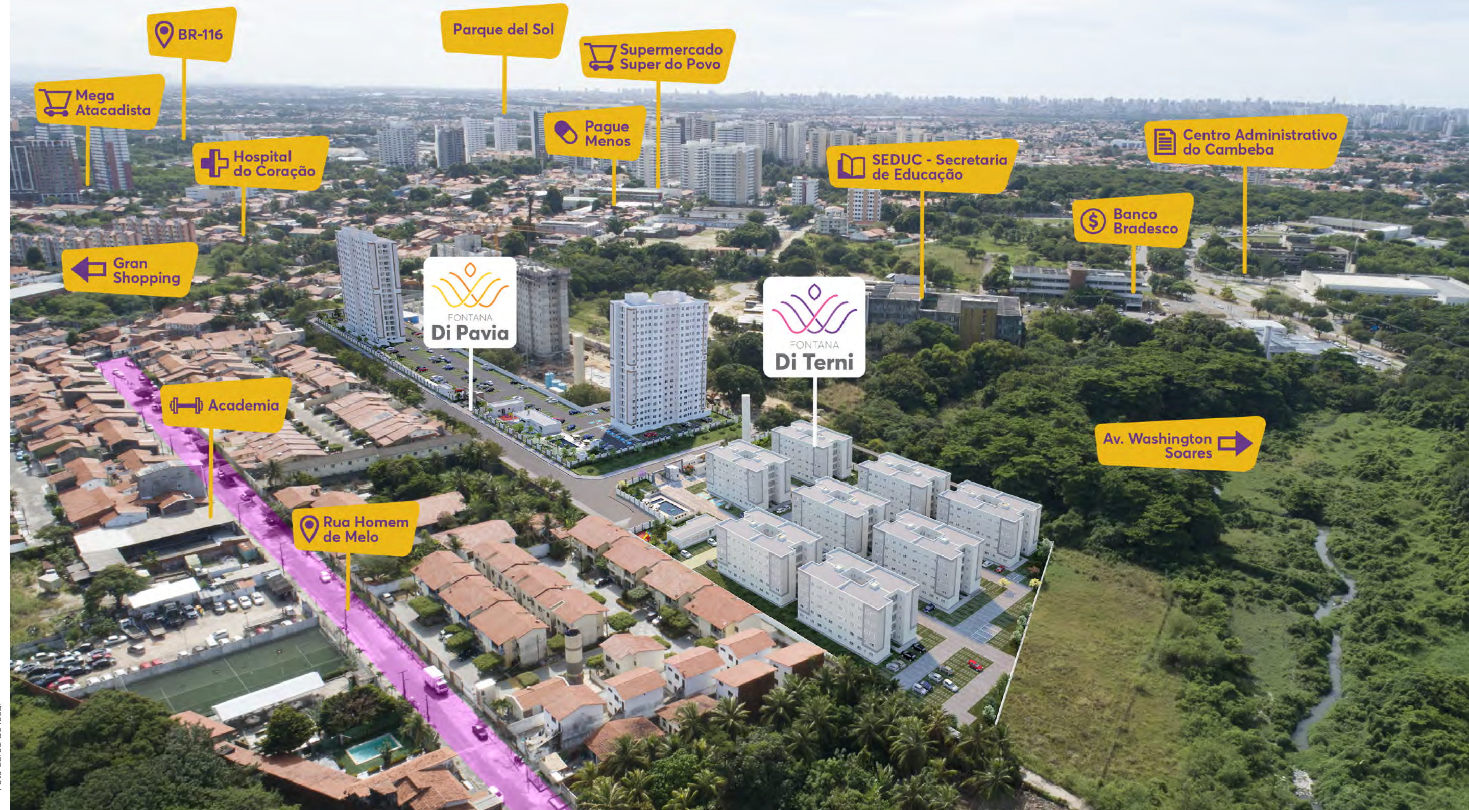
Foto aérea do local
